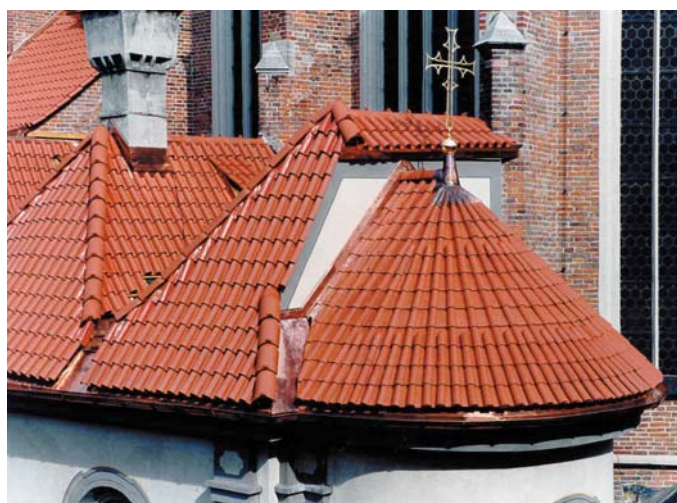
Das fertige Werk: Baukunst mit zeitgemäßer Technik
