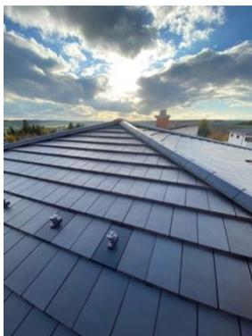
Installé tout simplement, fixé de manière sûre : le support de panneaux solaires ERLUS garantit une assise solide des modules solaires sans abîmer le toit ou les tuiles.
