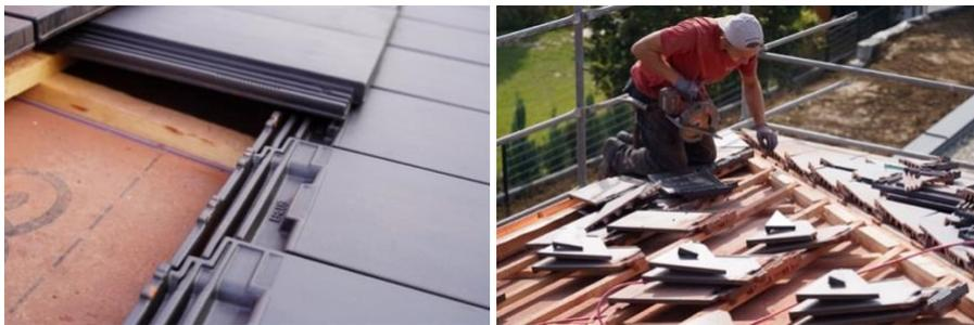
Image de gauche : La tuile Level RS® dispose d'un triple emboîtement au niveau de la tête et sur le côté. Cette particularité technique garantit une parfaite évacuation de l'eau à sa surface.
