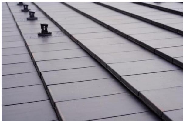
La mise en œuvre de la tuile plate Level RS<sup>®</sup> qui est certifiée selon la norme prEN 15601 a fait le bonheur des poseurs. En dépit de la faible pente cette tuile dispense les prescripteurs et les couvreurs de la mise en œuvre d'une sous-couverture fastidieuse et coûteuse. Or, cette étape aurait été indispensable avec des tuiles à pureau plat
