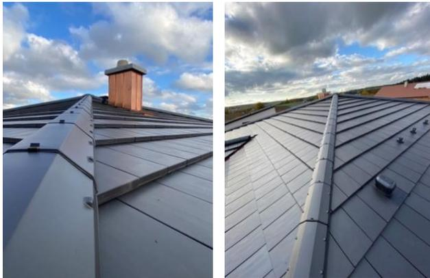
Les accessoires de marque ERLUS, tels que la tuile de ventilation sanitaire ou les supports de panneaux solaires, sont installés sur mesure et se montrent particulièrement robustes.
