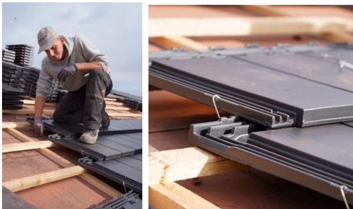
Le crochet tempête II d'ERLUS convient pour presque tous les modèles. Il est facile à mettre en place d'une seule main. La tuile elle-même possède des rainures anti-tempête largement dimensionnées dans lesquelles s'accrochent les crochets.
