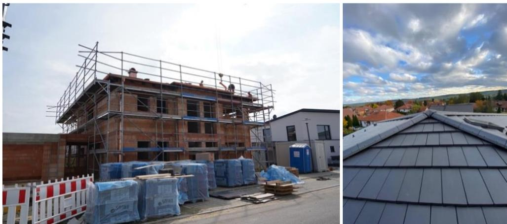
« Grâce à son triple emboîtement latéral et de tête, la tuile plate Level RS<sup>®</sup> peut être posée pour les pentes particulièrement faibles. Sur ce chantier, l'entreprise Poeschl a misé sur la nouvelle tuile pour faibles pentes d'ERLUS et un écran de sous-couverture HPV. »
