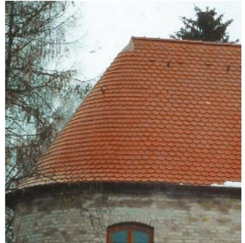
Bei diesem Kegelgedäch-Projekt mit Ergoldsbacher Biberschwanzziegeln können Sie sehr gut erkennen, dass alle Biber einer Reihe mehr oder weniger gleich groß sind. In der achten Reihe werden die sehr schmalen konischen Biber von breiteren übersprungen. Daraufhin werden die Reihen wieder schmaler.
