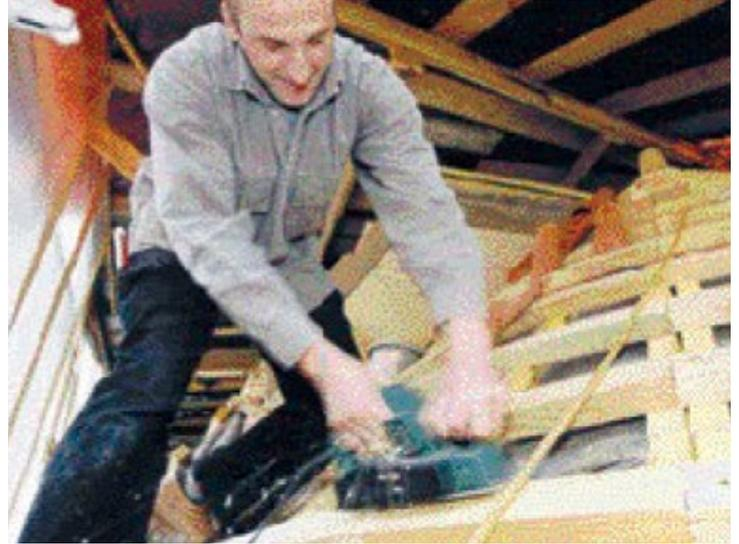
Zusätzlich ist es sinnvoll, die Stöße zweier Traglattenstücke mit einem elektrischen Hobel anzugleichen. Alle Nägel oder Schrauben sollten Sie konsequent versenken. Vorsicht bei sehr kurzen Lattungsstücken: Sie können beim Festschrauben aufreißen, wenn man nicht vorgebohrt hat.
