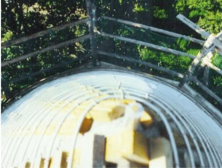
Von Kunststoffplatten raten wir aufgrund der mangelnden Praxisbewährung ab. Eine hölzerne Traglattung bleibt dagegen eine dauerhafte Lösung für Jahrzehnte oder gar Jahrhunderte. Diese wird in kurzen Stücken ausgeführt. Je enger und kleiner diese Stücke platziert werden, umso runder ist später das Erscheinungsbild der gesamten Eindeckung.
