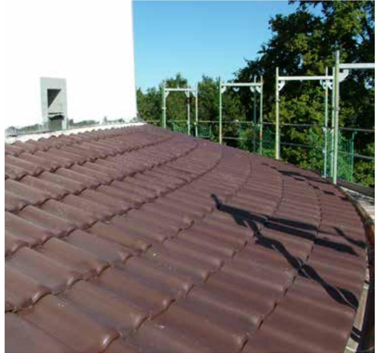
Bei gerundeten Dachflächen, wie z.B. dieser Reihenhäuseranlage hier in Olching bei München, wurden E58 MAX Dachkeile eingesetzt, welche traufseitig eine Deckbreite von 32 cm und am First von 10 cm aufwiesen.
