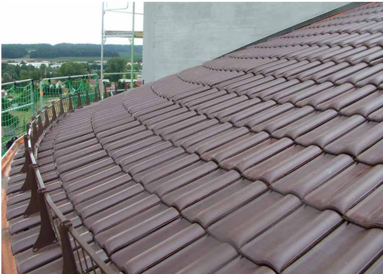
Am Projektbeispiel der Sanierung des Holledauer Doms der Pfarrkirche in Rohrbach mit dem Ergoldsbacher E58 S konnte durch das Einbringen von Dachkeilen in jeder Reihe die vollkommene Rundung der Apsis wiederhergestellt werden.
