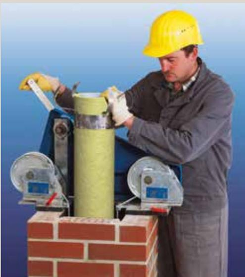
Versetzen des ERLUS Edelkeramik® Sanierungssystems W3G mit einer Versetzwinde.
