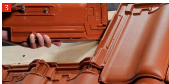
Sperrzahnmuttern an der Unterseite der ALU Grundplatte mit 16 Nm anziehen.
