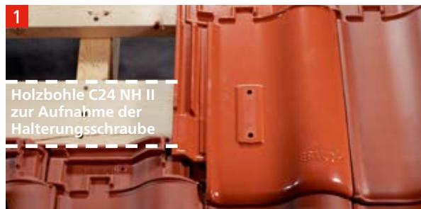
Holzbohle, C24 NH II (mind. 40 mm stark bei 30/50er Lattung, bzw. mind. 50 mm stark bei 40/60er Lattung, 150 mm breit), mit 3 Stück mind. 6 mm Holzschraube auf jeden Sparren befestigen; die Schrauben müssen mind. 40 mm in eine statisch angesetzte Konterlattung oder bei geringeren Konterlattenquerschnitten mind. 40 mm in den Sparren eindringen.
