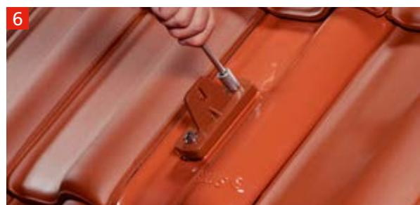
Solarträgerelement auflegen und mit Stecknuss 13 mm (mit 16 Nm) auf den in Bild 5 eingedrehten Köpfen der Holzschrauben abstützend montieren.
