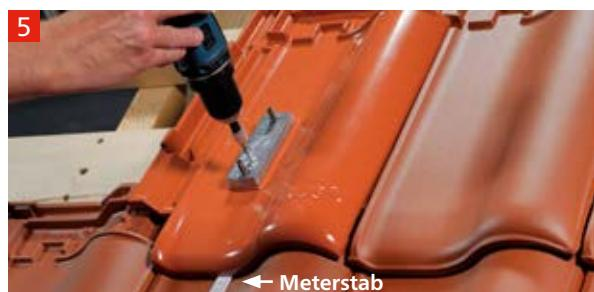
Befestigung der ALU Grundplatte mit beiliegenden 6 mm Holzschrauben; ein untergelegtes Meterstabblatt oder die rückseitigen Stützfüße dienen als wenige mm starker Distanzhalter; im Kopffalz werden die beiden mit gelieferten Schrauben inkl. Dichtung eingeschraubt.
