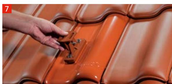
Verstellbares Oberteil des Solarträgerelementes parallel zur Sparrendachneigung montieren (Voreinstellung von 4° bei profilierten Ziegeln bzw. 8° bei Biber Kronen-deckung möglich); durch das Spannen einer Schnur können dann alle Halterungen in der gleichen Höhe ausgerichtet werden.
