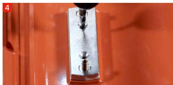
Bohren der Löcher durch die ALU Grundplatte (Bohrer 6 mm) zur Befestigung in die Bohle.
