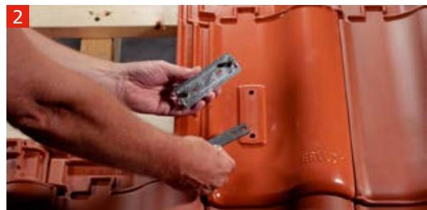
Mehrteiligen Solarträger-Aufsatz trennen und das untere Teil inkl. Dichtung auf der ALU Grundplatte befestigen.
