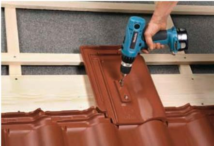
5. Bohren der Löcher durch die Alu-Grundplatte (Bohrer 8 mm) zur Befestigung in die Bohle.
