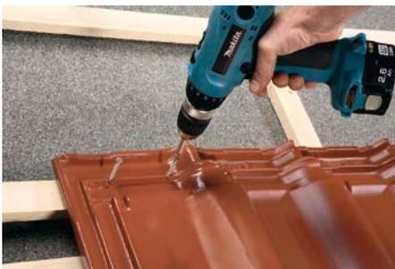
7. Befestigung der Grundplatte in der Traglatte mit V2A-Schrauben 5/60 mm inklusive möglicher Dichtungen (Kopffalzbereich).
