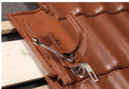
10. Beide Elemente werden jetzt mit den zwei Edelstahlmuttern auf dem Aufsatzelement verschraubt. Die Edelstahlscheibe wird unter die M 10 Mutter (unten) gelegt.
