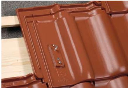
6. Befestigung der Grundplatte in der Bohle mit V2A-Schrauben 8/100 mm.
