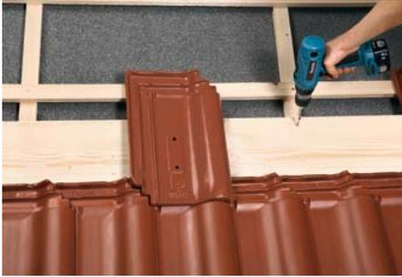
1. Holzbohle, S10 (in Lattenstärke, jedoch mind. 40 mm Dicke und 150 mm Breite), zur Aufnahme der Halterungsschrauben (mit je 3 Holzbauschrauben) auf den Sparren anschrauben. Die Schrauben müssen mind. 8 cm in den Sparren eindringen (Konterlattenhöhe bzw. evtl. Schalung beachten).
