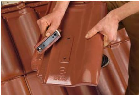
3. Das Aufnahmeelement (mit dem Pfeil Richtung Traufe) mit Flachdichtung auf der Alu-Grundplatte verschrauben.
